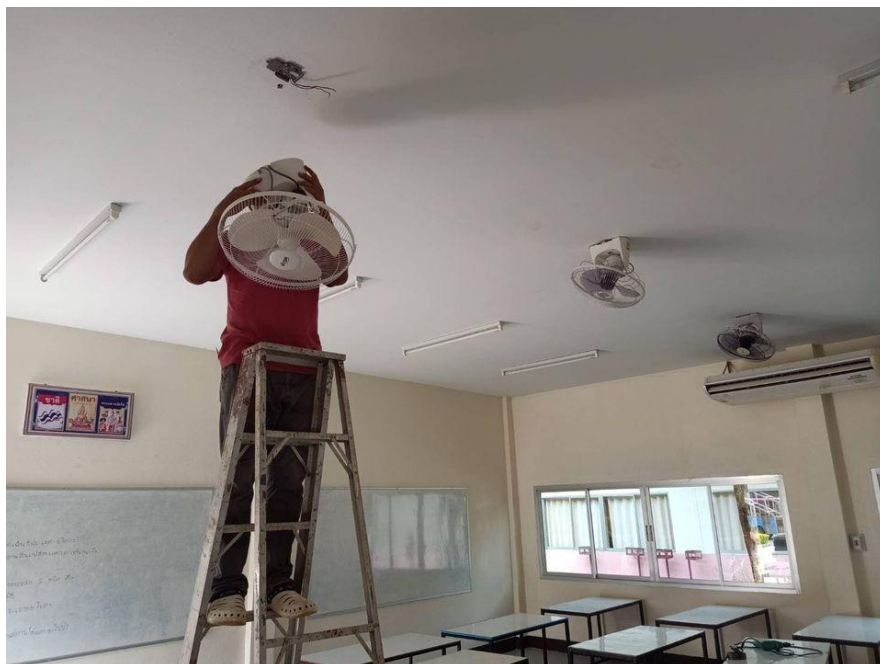
ติดตั้งพัดลมแทนพัดลมที่เสีย
