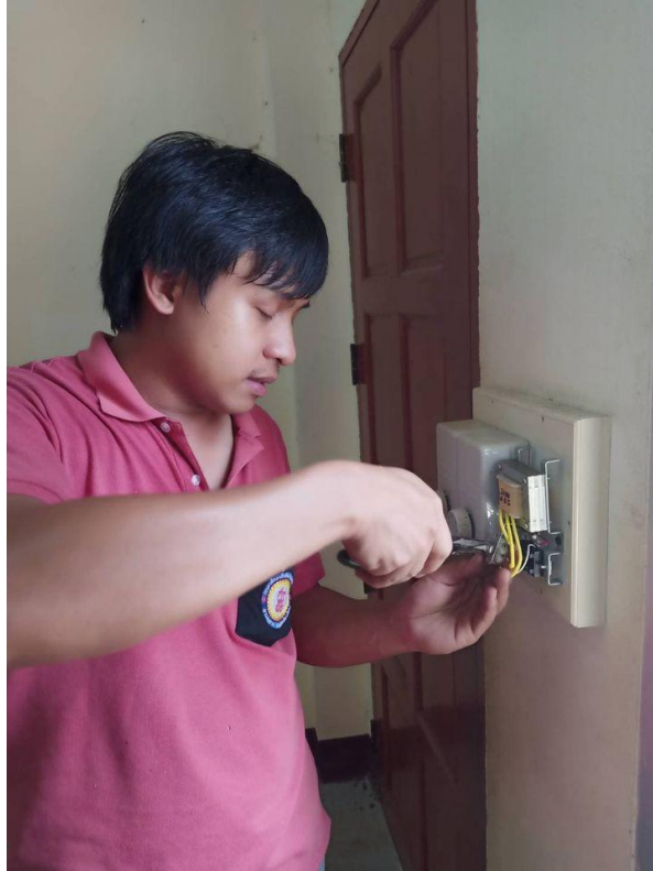
เปลี่ยนอุปกรณ์ไฟฟ้าและซ่อมแซม
