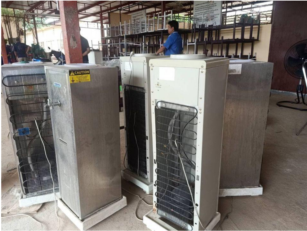
ซ่อมแซมเครื่องทำน้ำเย็นหอพัก
