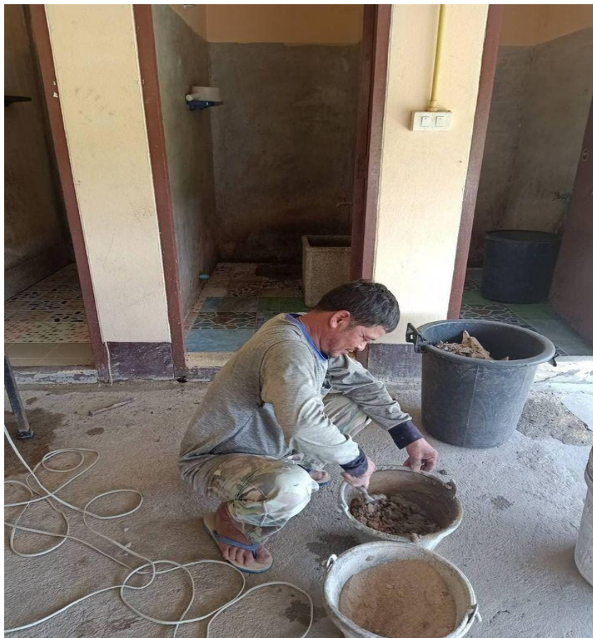
ปรับปรุงซ่อมแซมต่อเติมห้องน้ำวิทยาลัย
